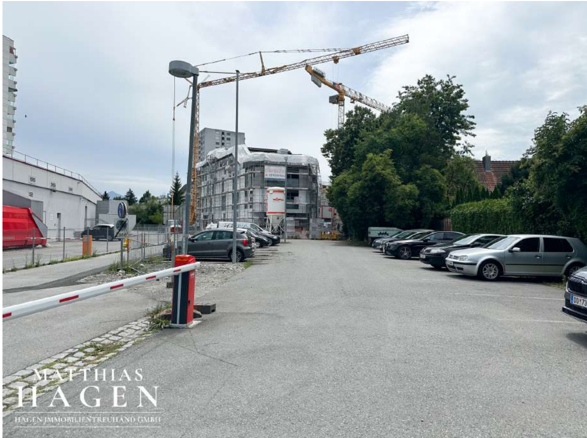
Parkplatz mit Schranke
