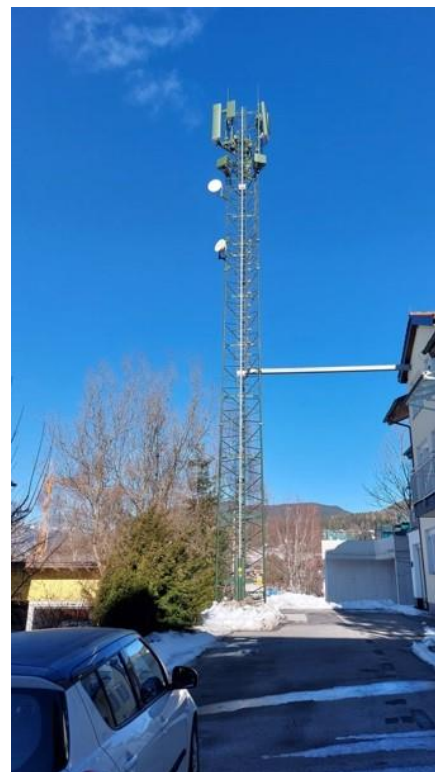
Gitterrohrmast der A1 Towers Holding GmbH
