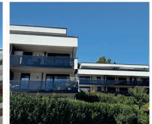
Wohnanlage – Gaisberg Terrassen – Vomp
