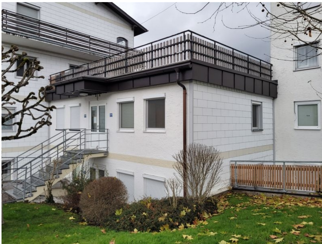
Verbindungsbau mit Flachdach.jpg
