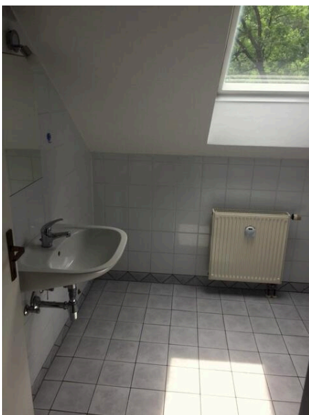
Fenster und Waschmaschinen-Anschluß
