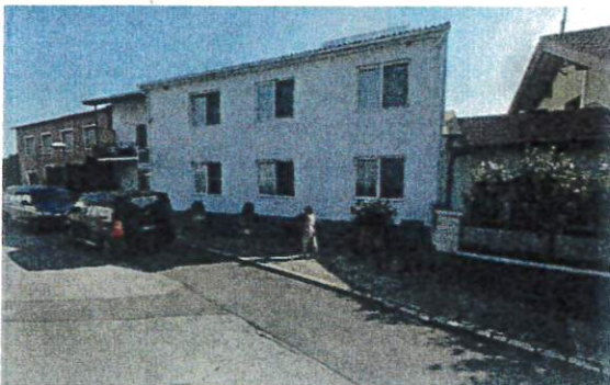
Abbildung 157: Blick entlang Julagasse, Standort Hn. 3, Blick Richtung Norden; Google Street View Juli 2024
