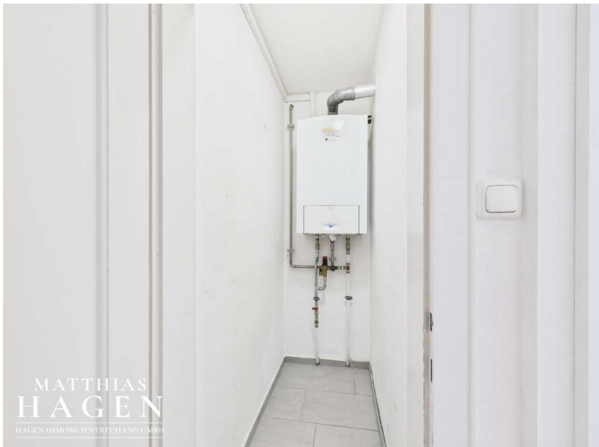
Abstell- und Heizraum
