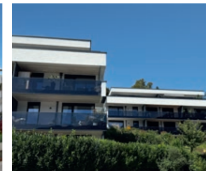
Wohnanlage – Gaisberg Terrassen – Vomp
