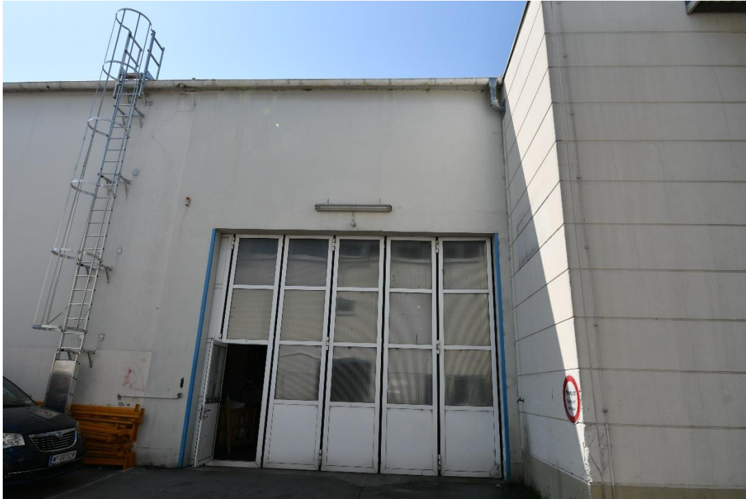
Bild 5: Ansicht Nordost, Rücksprung
