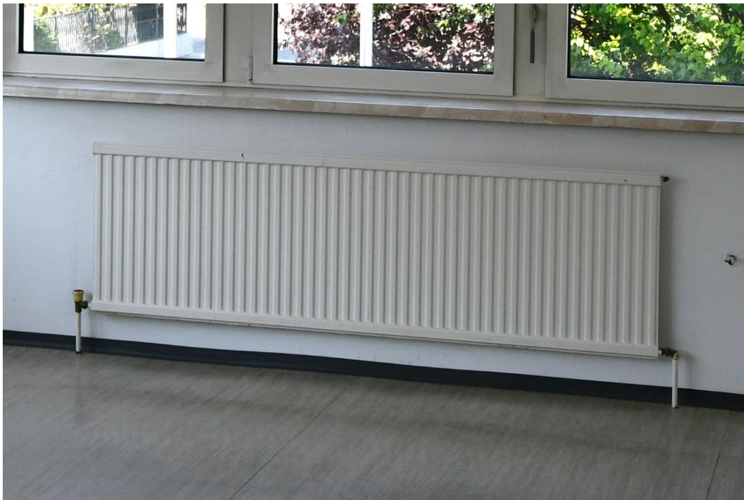
Bild 23: Heizkörpertyp 3: Flachheizkörper mit Handrad
