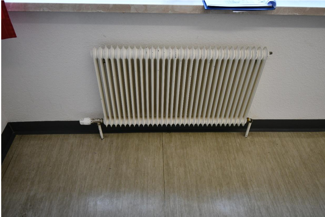
Bild 22: Heizkörpertyp 2: Gliederheizkörper mit Thermostatkopf
