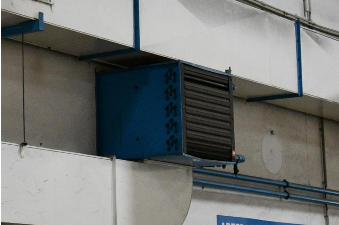
Bild 24: Gebläsekonvektor Lagerhalle
