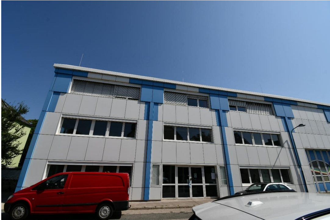
Bild 1: Ansicht Südwest links
