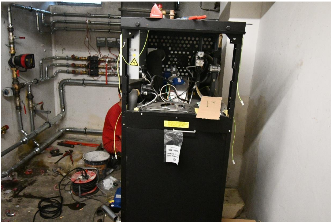
Bild 20: Installation der neuen Heizungsanlage während der Besichtigung
