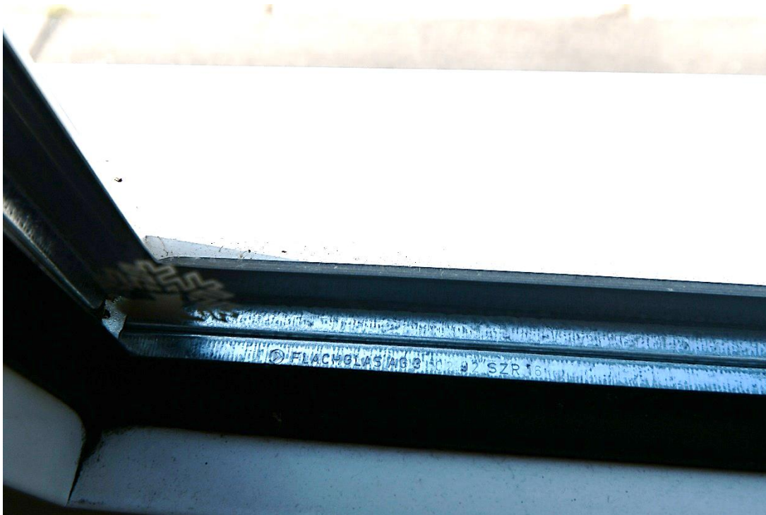
Bild 11: Glasstempel Fenster, Alu-Rahmen, 2-Scheiben ISO-Glas
