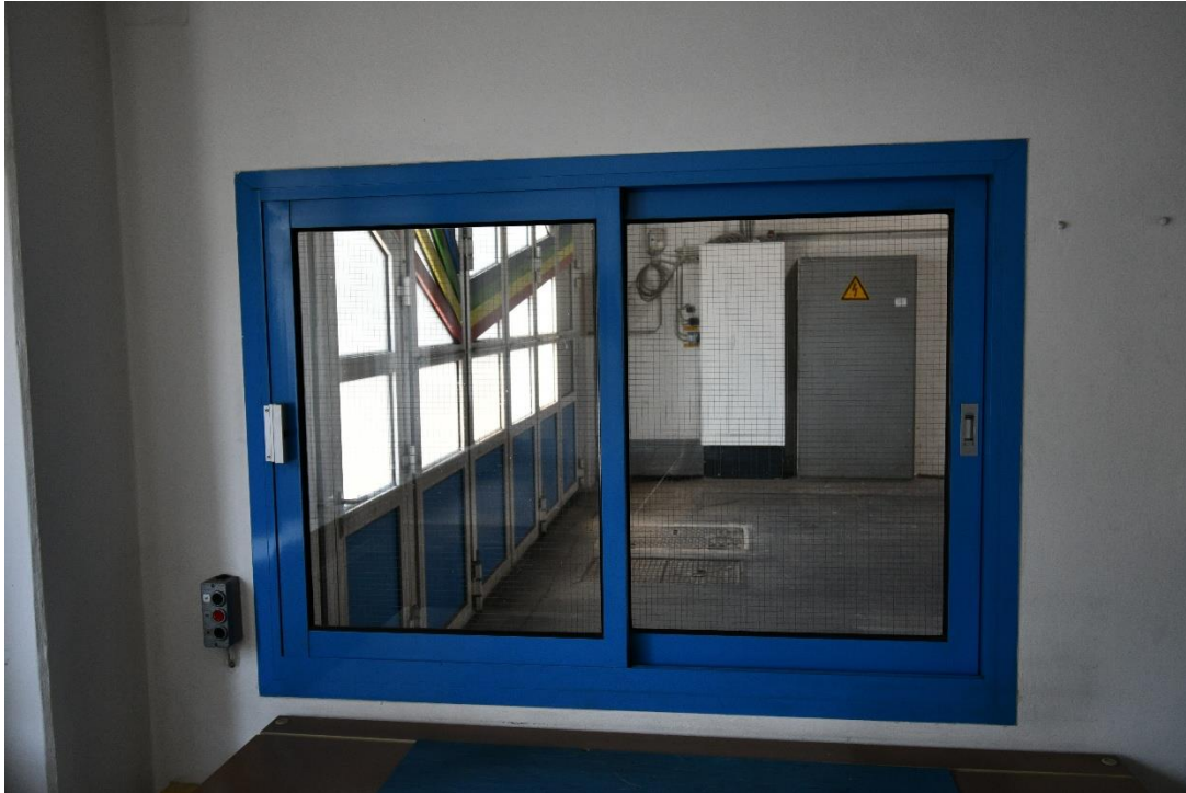
Bild 19: Innenfenster Aluminiumrahmen mit Drahtglas, 160 x 113
