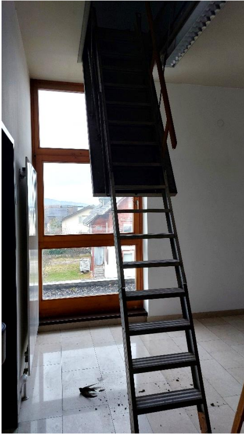
Dachbodentreppe im Stiegenhaus 1.01 im 1.OG
