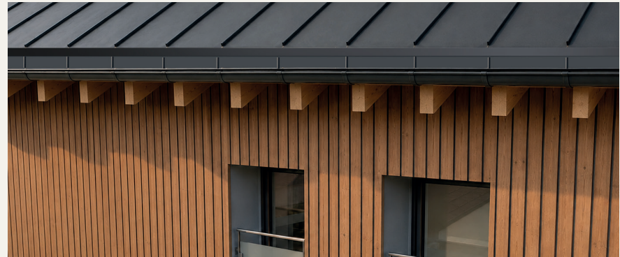
Lärchenfassade natur und Falzblech Anthrazit Dach
