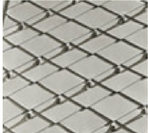
Dachfläche Prefa Dachraute 44x44 Prefabronze
