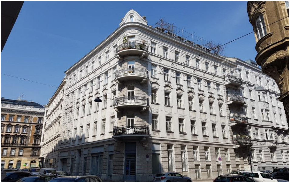
Ansicht Südost Quelle: eigene Aufnahme
