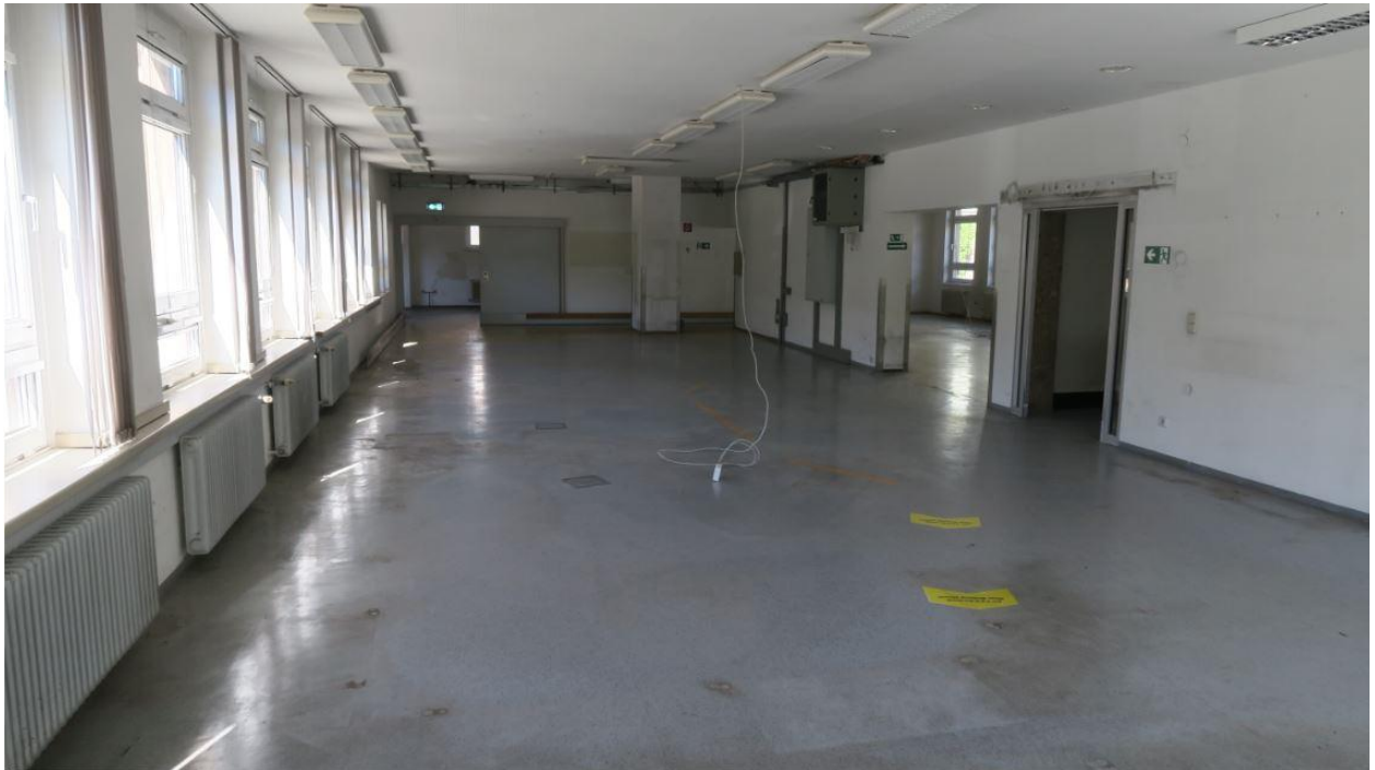
EG - ehem.Zustellbase – Raum E.02
