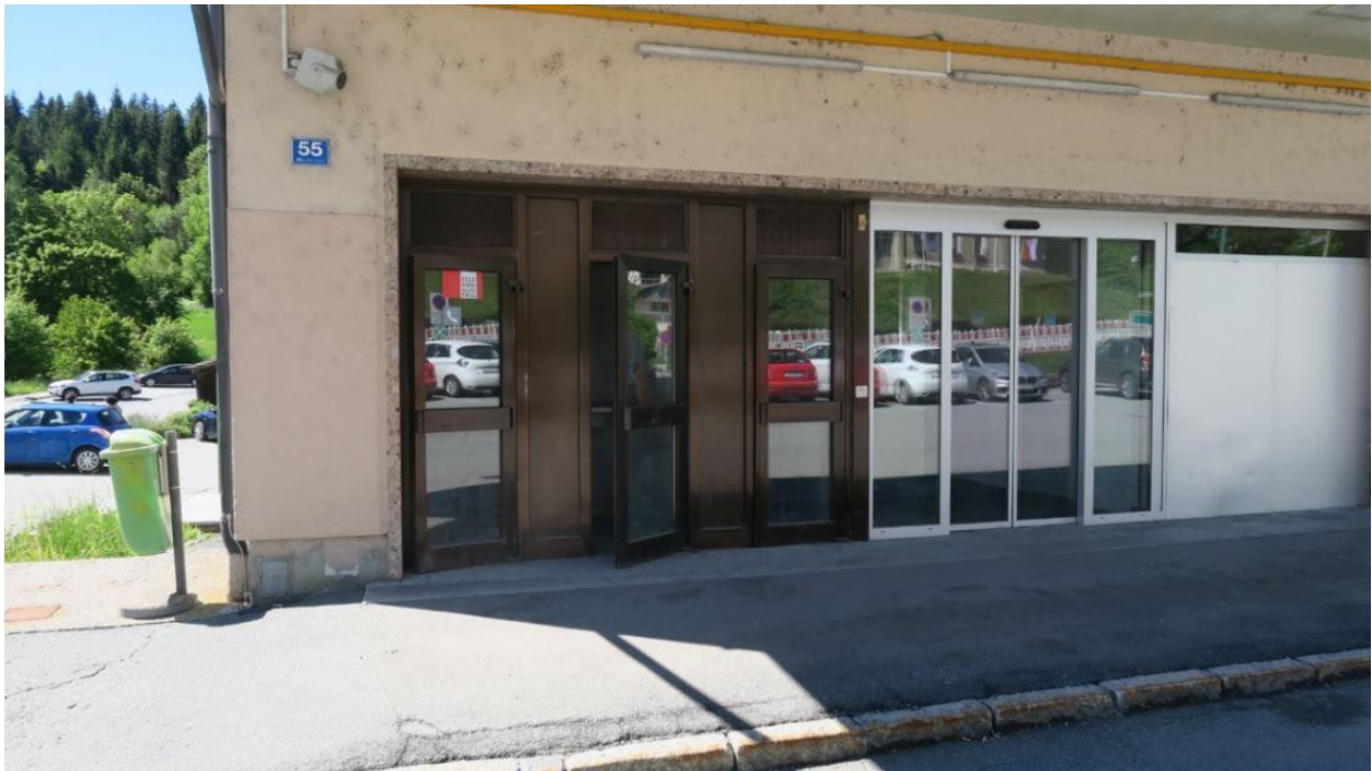
Ehemalige Fernsprechkablen – A1 TA AG
