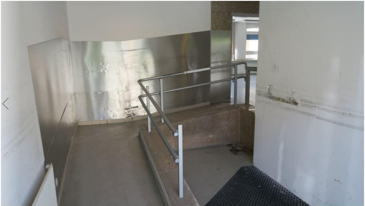
EG - ehem.Zustellbase – Raum E.01
