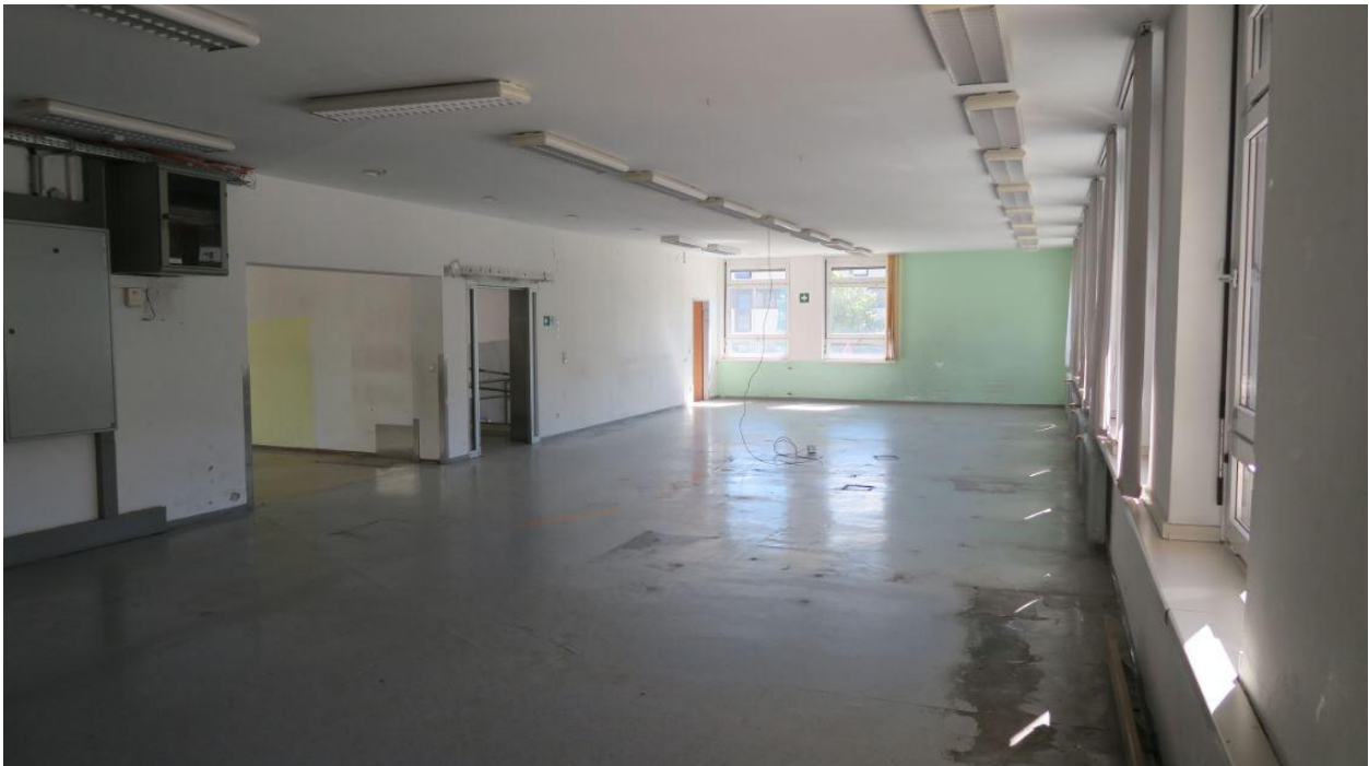
EG - ehem.Zustellbase – Raum E.02
